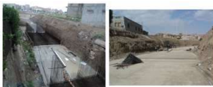
Fig. 2: Les travaux de réalisation lancées depuis 2010
