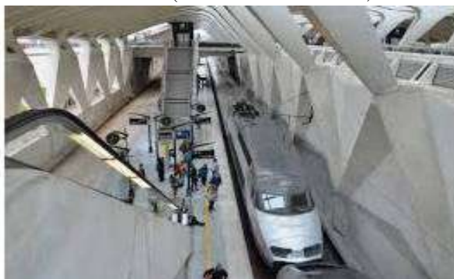
FIG 5. PROJET : VUE DE LA STRUCTURE DU PROJET : GARE SAINT-EXUPERY, LYON, FRANCE, 1994. SANTIAGO CALATRAVA (CAPTURE D'ÉCRAN, MOULOU CHAABI, 2019)
