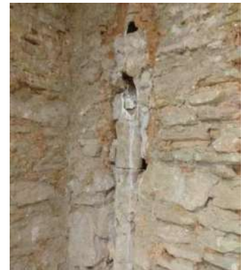
Vacuation des eaux pluviales
