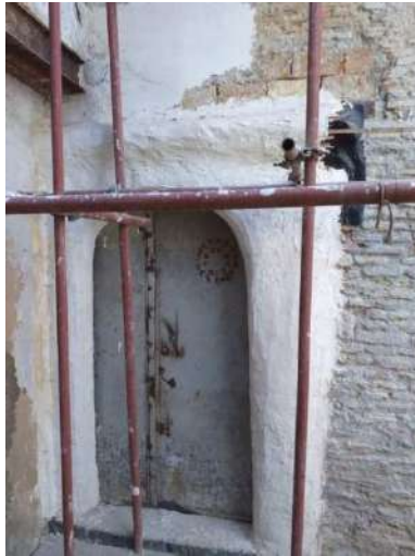
Entrée de la maison à partir du niveau semi-enterré (11)
