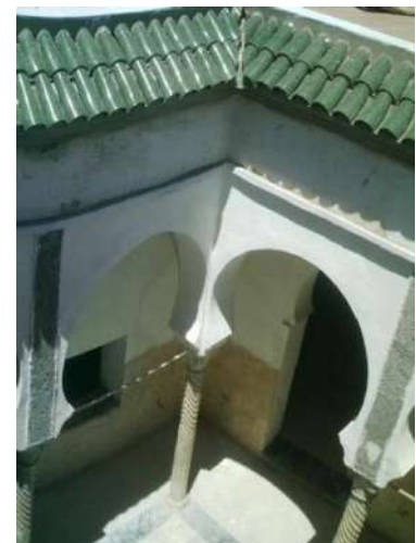
Parapet au dessus du patio (44)
